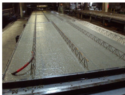
Das fertige Bauteil.
