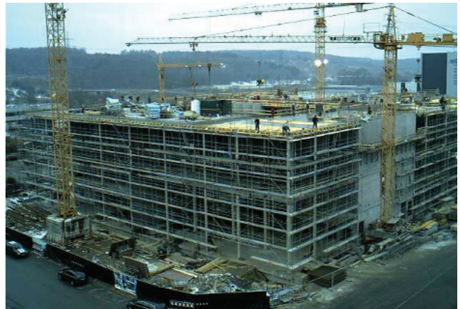
1840 Tonnen Betonstahl - verlegt in nur 5 Monaten! Verwaltungsgebäude Hugo Boss in Metzingen
